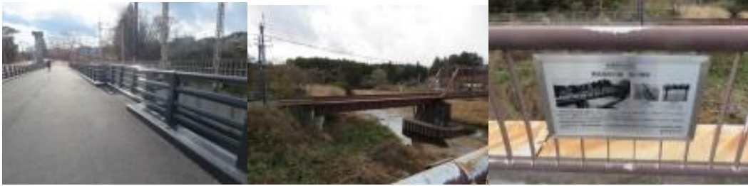
※中岩橋(鬼怒川)、砥川橋梁
